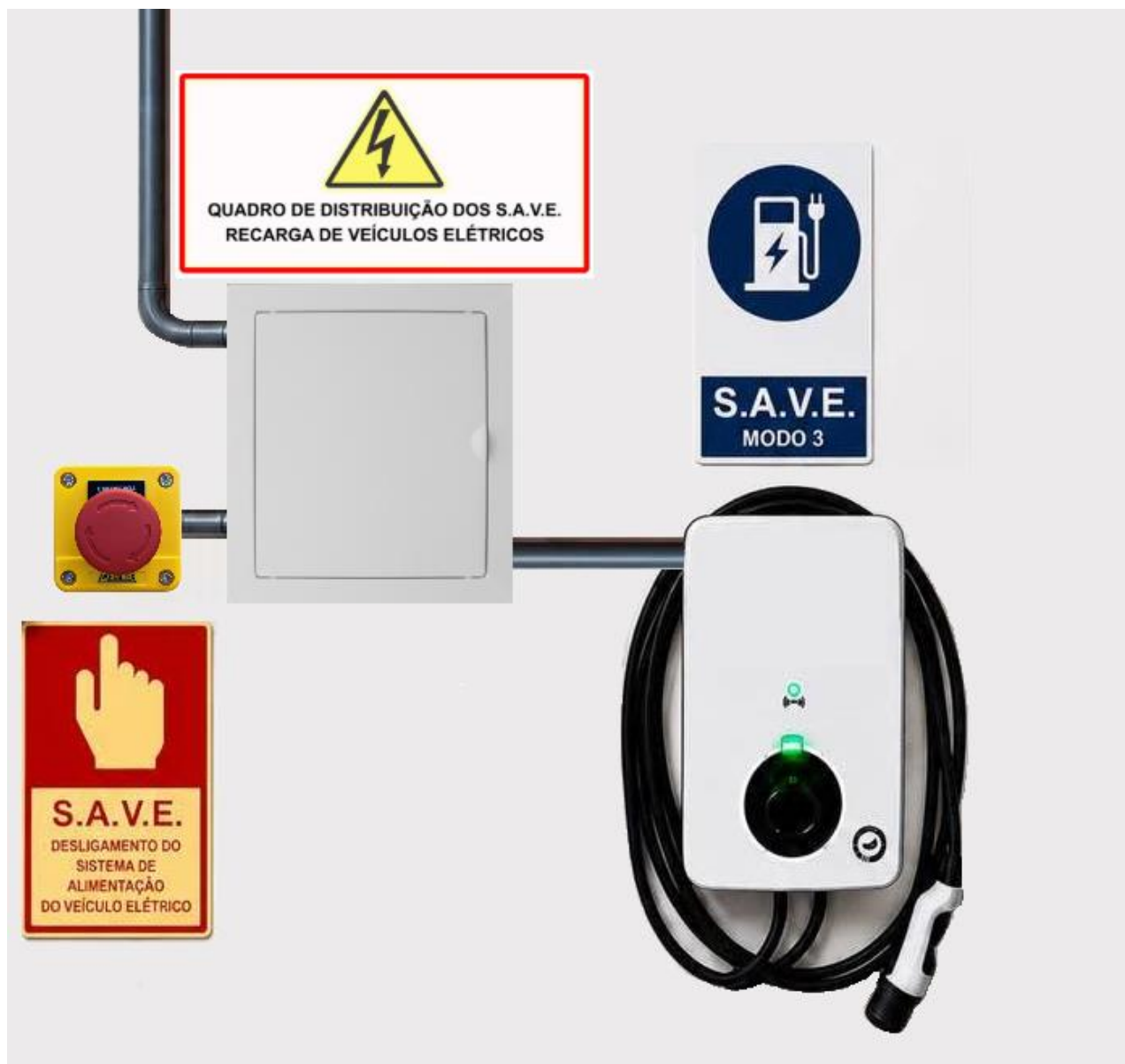
Figura 9: Exemplo de detalhe das sinalizações dos componentes do SAVE em uma vaga de estacionamento.
